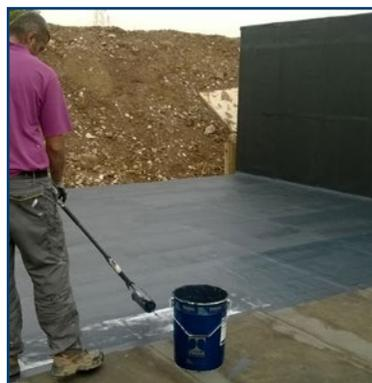
Membrana acrilica monocomponente in base acquosa, impermeabile ad elevata resistenza ai ristagni d'acqua. È un prodotto a base di resine sintetiche che presenta un'elevata elasticità ed un'ottima adesione al supporto. Possiede un'elevata resistenza agli agenti atmosferici e agli sbalzi di temperatura. Resiste ai raggi UV e alle aggressioni atmosferiche. Disponibile in diverse colorazioni.
