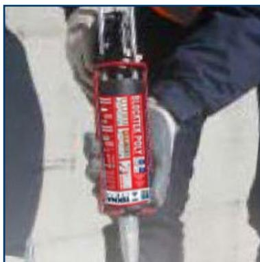
Bicomponente in resina poliesteri impiegata per la realizzazione di ancoraggi chimici in muratura piena, semipiena o forata.
