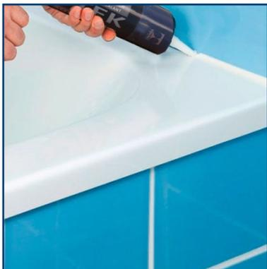
Sigillante siliconico, monocomponente a polimerizzazione acetica, impermeabile. Garantisce un'adesione elevata per i più comuni materiali da costruzione non porosi.
