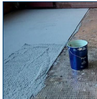
Resina epossidica bicomponente a bassissima viscosità specifica per massetti senza solventi. Consente di ottenere un massetto a spessore ed un ottimo ancoraggio sulla maggior parte dei supporti anche se finemente porosi. Spessore anche di 5 mm.
