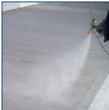
Antieaporante, antipolvere, in soluzione acquosa, pronto all'uso. Protezione delle superfici di calcestruzzo fresco dall'evaporazione superficiale con caratteristica finale antipolvere. Spruzzato sulla superficie del calcestruzzo fresco, forma un film continuo e tenace capace di limitare l'evaporazione dell'acqua.
