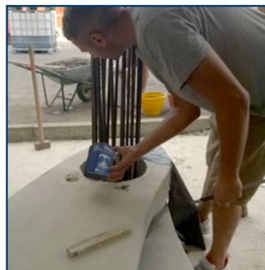
Resina epossidica bicomponente a bassa viscosità, stabile in ambiente alcalino e senza solventi ad alto potere adesivo. Impiegata per il ripristino di strutture, per riempimenti di fessure o livellamento di superfici piane in calcestruzzo e per riprese di getto tra calcestruzzi nuovi e calcestruzzi preesistenti. Disponibile nella versione estiva ed invernale.
