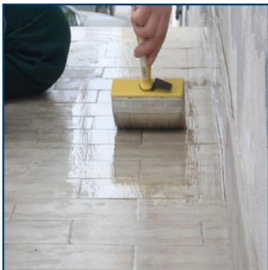
Soluzione concentrata a base di resine siliciche, silani, silossani e polimeri organici, impiegata per l'impermeabilizzazione di superfici orizzontali aventi macroporosità e cavillature dalle infiltrazioni d'acqua.
