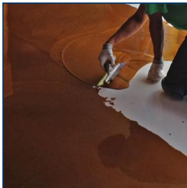
Malta epossidica autolivellante bicomponente trasparente, specifica per la realizzazione di pavimentazioni architettoniche in resina.
