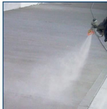
Antieaporante in soluzione acquosa pronto all'uso. Protezione delle superfici di calcestruzzo fresco dall'evaporazione superficiale. Spruzzato sulla superficie del calcestruzzo fresco, forma un film continuo e tenace capace di limitare l'evaporazione dell'acqua. Non crea pregiudizio a riprese di getto e trattamenti superficiali.
