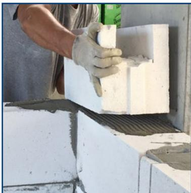
Adesivo cementizio monocomponente per l'incollaggio di blocchi in cemento cellulare autoclavati.
