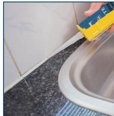
Adesivo e sigillante monocomponente a base di speciali polimeri acrilici in dispersione acquosa, ecologico e senza solventi. Sigilla perfettamente tutte le situazioni più frequenti in edilizia: sanitari e lavabi, giunti di raccordo, tra muri e infissi, finestre, porte, pluviali, lucernari etc. Grazie alla sua composizione, con speciali polimeri acrilici, sviluppa delle grandi doti adesive per tutti i materiali di maggior uso. Disponibile in bianco.
