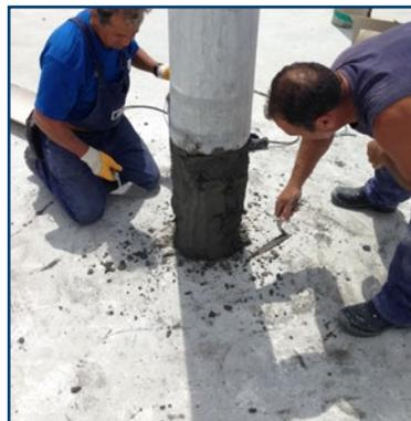
Malta cementizia monocomponente fibrorinforzata, reoplastica e tixotropica, a ritiro compensato specifica per ripristini strutturali, manutenzione e restauro delle strutture in calcestruzzo soggette ad elevata aggressione chimico/fisica ed ambientale.
