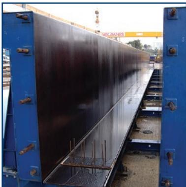
Disarmante universale, a bassa viscosità adatto a tutte le tipologie di casseformi metalliche ed in legno, impiegato per manufatti in calcestruzzo specialmente per quelli di grandi dimensioni. Il disarmante garantisce un'ottima protezione attraverso una semplice applicazione anche alle basse temperature, favorendo lo scasseramento.
