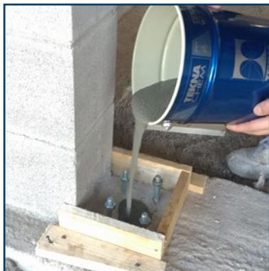
Malta cementizia monocomponente autolivellante a ritiro compensato, pronta all'uso e colabile per realizzare ancoraggi di precisione di macchinari pesanti e strutture in calcestruzzo.
