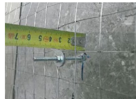
Particolare fissaggio rete elettrosaldata
