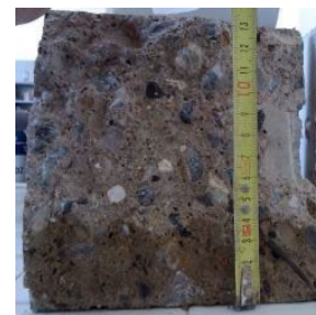
Cls senza Aeternum con additivo impermeabilizzante
